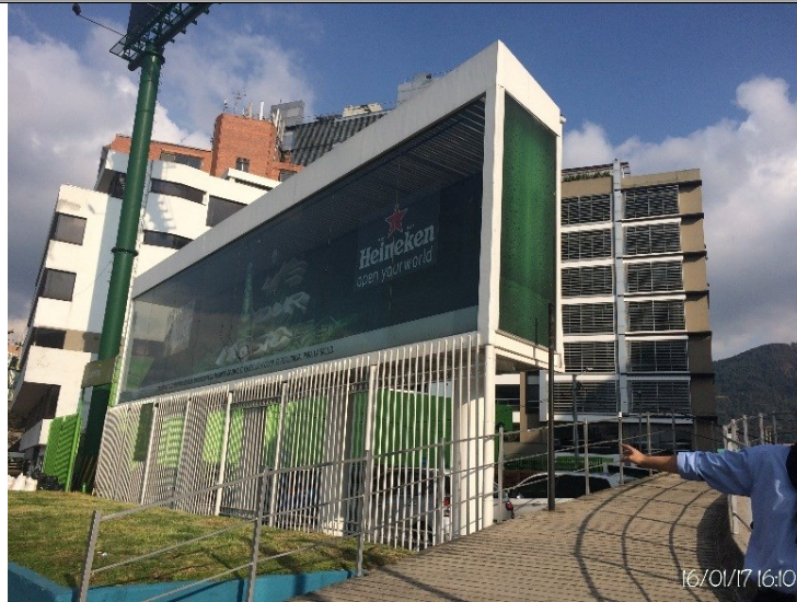
Fotografía No. 3. El predio cuenta con Publicidad Exterior Visual dentro de una edificación montada sobre pilares y con una fachada en vidrio orientada hacia la vía pública (conducta 4 evidenciada). Fecha de la Visita: 16/01/2017
