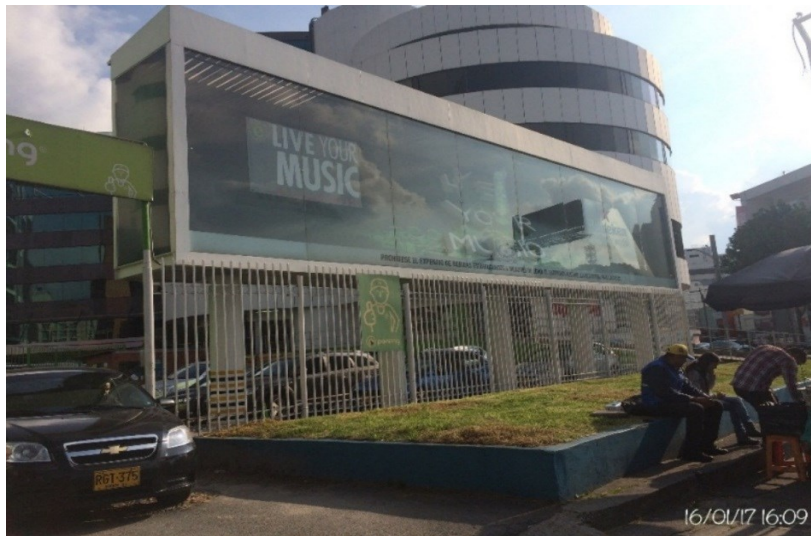
Fotografía No. 3. El predio cuenta con Publicidad Exterior Visual dentro de una edificación montada sobre pilares y con una fachada en vidrio orientada hacia la vía pública (conducta 4 evidenciada). Fecha de la Visita: 16/01/2017
